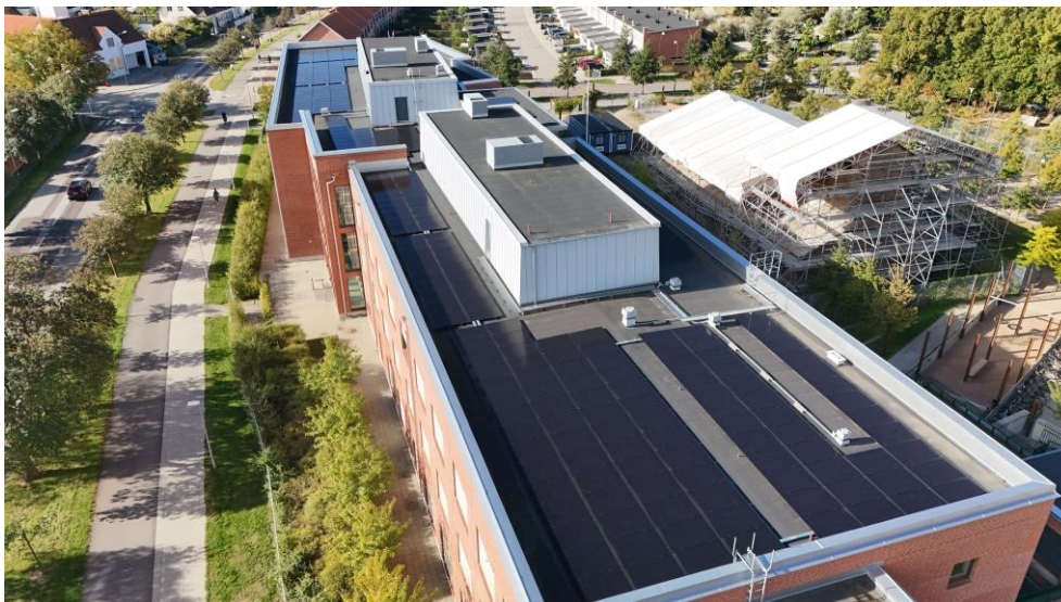
Figur 3. Stadsfastigheters solcellsprojekt på Limhamnsskolan. Solcellsanläggningen storlek är 133 kWp och den genererar årligen 117 MWh el. Bild: Stadsfastigheter.
