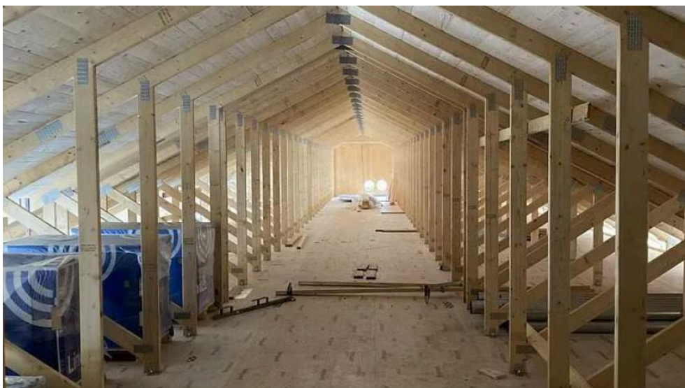
Figur 4. Trästommen på flerbostadshuset Rapsen. Bild: MKB Fastighets AB.
